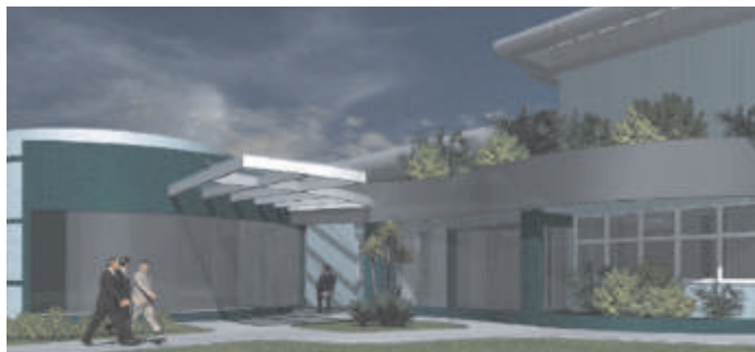
PETROBRÁS Prédio do Laboratório da FAFEN
